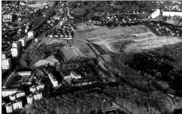
■ Les premiers travaux sur le site, en 1966. Photo DR
